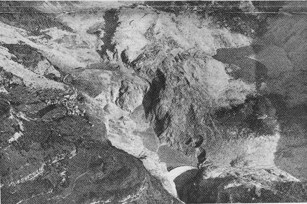
BELLUNO - Una visione aerea della diga del Valont, dopo che dalle pendici del monte Toc (sulla destra della foto) è precipitata un'enorme frana di terra e di rocce nel bacino idroelettrico. L'acqua è stata spazzata in parte, come si vede, da questa massa rocciosa; e l'ondata gigantesca, formata da 60 milioni di metri cubi d'acqua, ha superato la difesa della diga rovesciandosi nella valle, seminando morte e distruzione.
