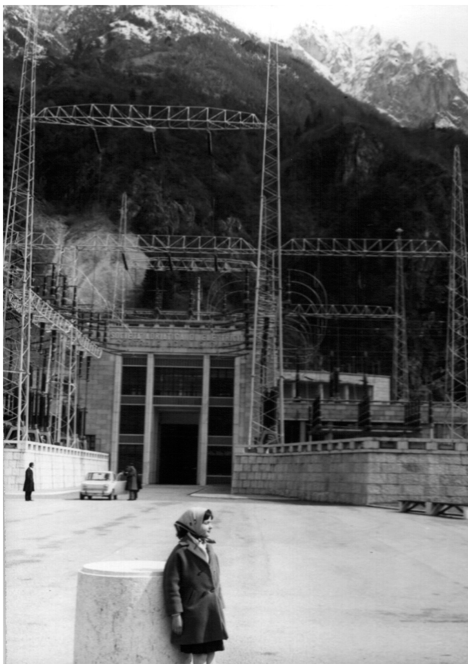
La centrale nel 1963
